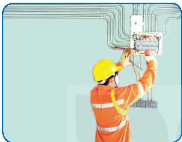
Hình 7.1. thợ điện thực hiện công việc lắp đặt thiết bị đóng cắt mạng điện trong nhà
